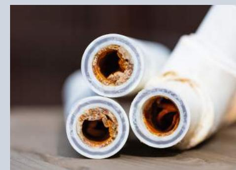
Raccordi idraulici e tubature ostruite da calcare
